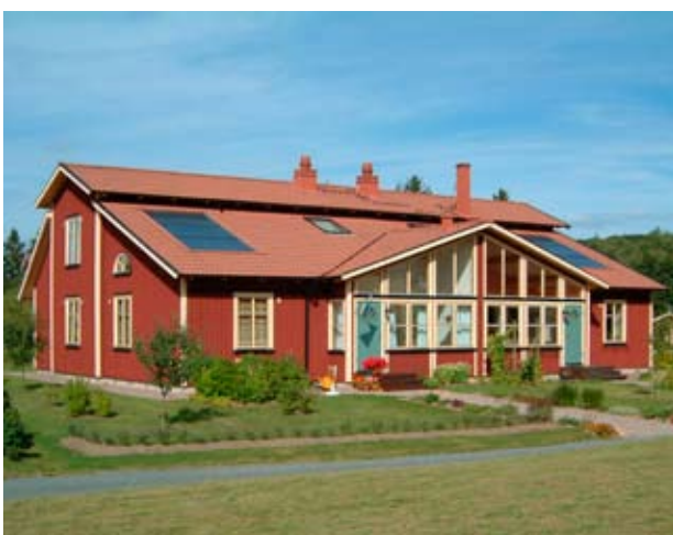
Parhus med solfångare i nedfällt montage.
